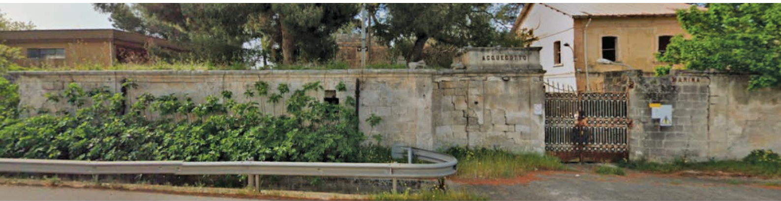
Ingresso ex Acquedotto Marina sulla strada di San Giorgio (Fonte: Street View)
